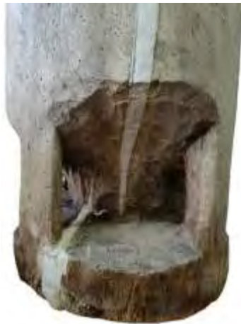
Fig. 2. În timpul restaurării.
