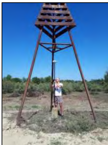
Fig. 2. Bornă geodezică cu piramidă la sol – zona Mahmudia-Murighiol (km 84,5).
